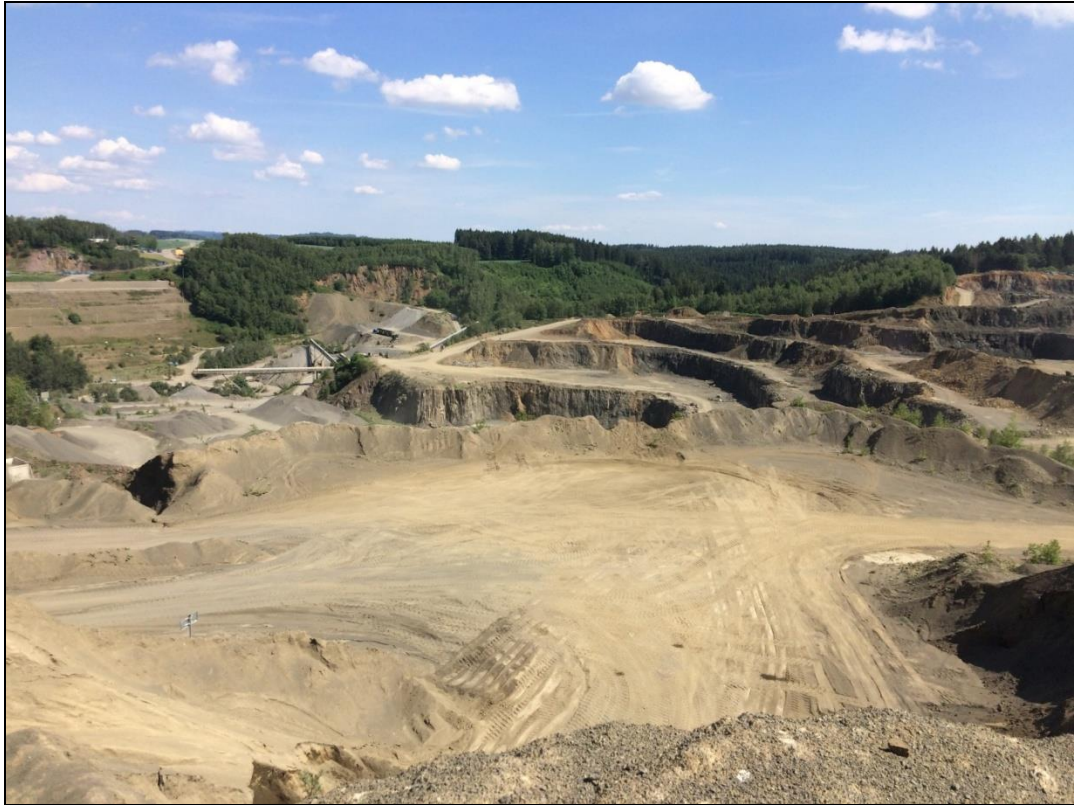
Obrázek č.3 Výsypka a výsivky na vytěžené části ložiska stavebního kamene v DP Košťálov II.
